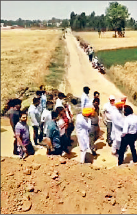
अंबाला। अंडरपास निर्माण के पास जमा किसान।
